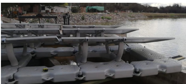
Ilustración 8: Montaje del piloto Flotante PV en la orilla del embalse Hospital.
