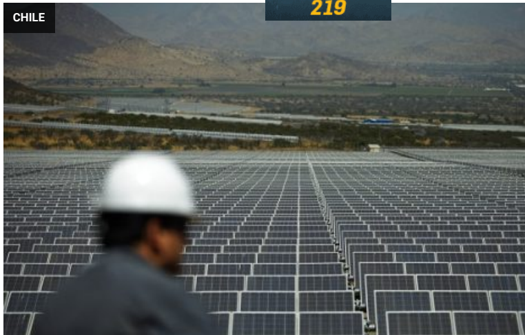
CHILE Planta solar Quilapilún en Región Metropolitana. Foto: Juan Carlos Recabal-Revista ELECTRICIDAD.
