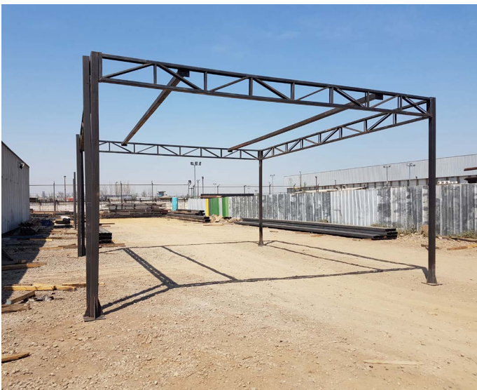
Planta en construcción en dependencias CINTAC.
