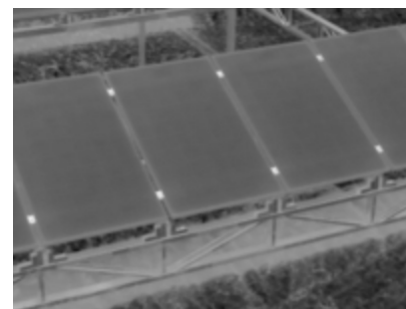
Foto de prueba de análisis termográfico Planta Lampa (en tonos grises) – Tecnología de detección anticipada de fallas en paneles fotovoltaicos
