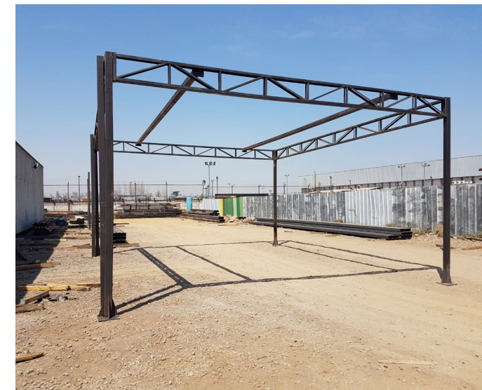
Planta en Construcción en Dependencias CINTAC
