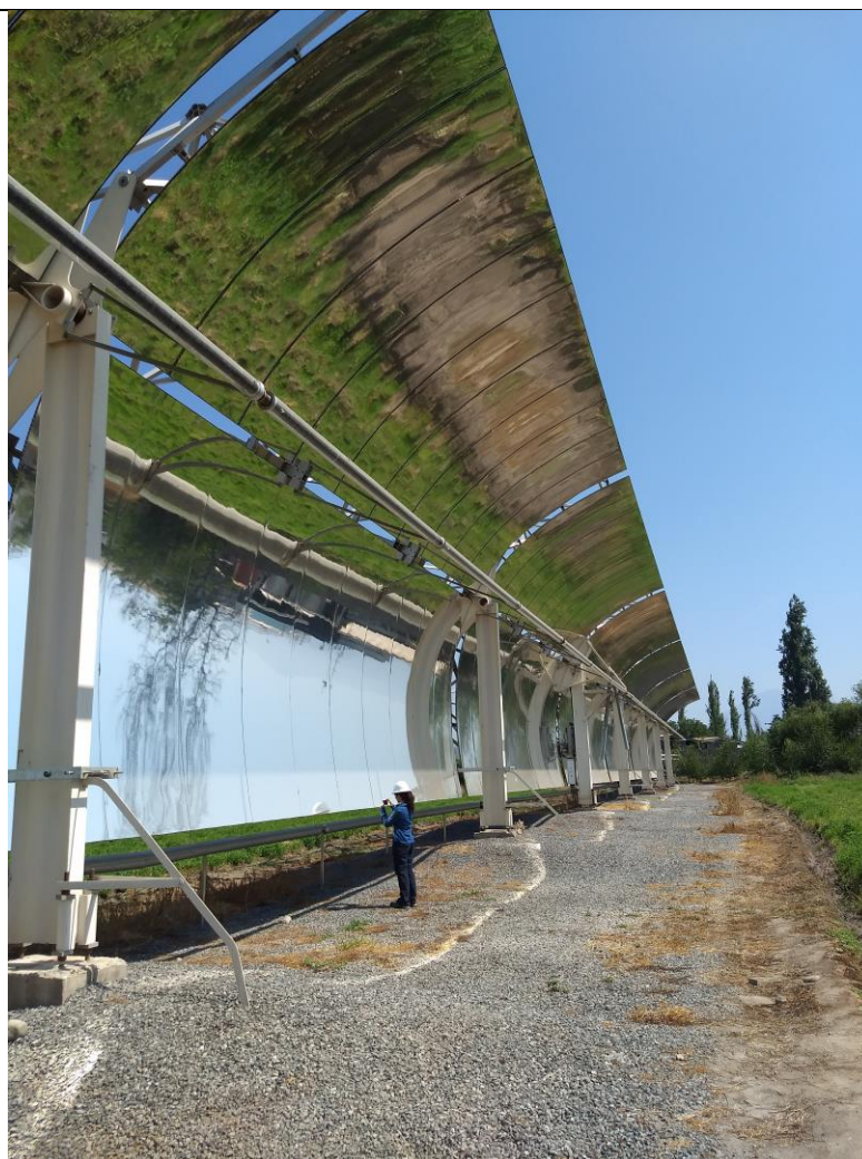
Figura 31 - CSET realizando evaluación de colectores cilindro-parabólicos en planta de concentradora de jugos
