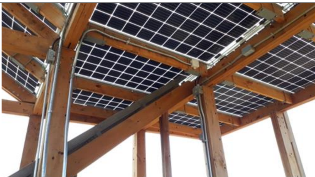
Figura 23 - Canalizaciones eléctricas
