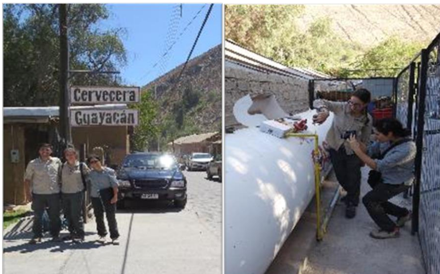
Figura 33 - Equipo Sistemas Solares Térmicos en Cervecería Guayacán
