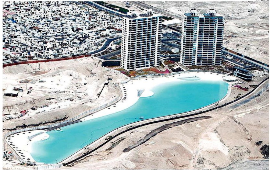
EL PROYECTO SE LEVANTARÁ EN EL SECTOR COSTA LAGUNA, DONDE LA EMPRESA CONSTRUYÓ Y OPERA UNA DE SUS LAGUNAS ARTIFICIALES.
